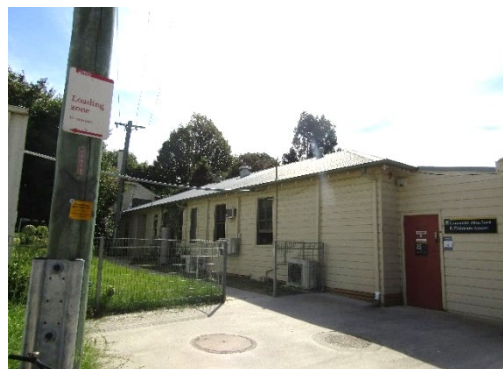
UPCC (Building 75E&F)
